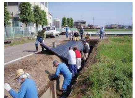
(防草シートの設置)
